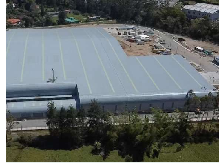
Planta de corrugados SKC, Guarne
